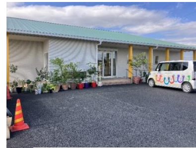
建物外観。まだ一部工事中です
